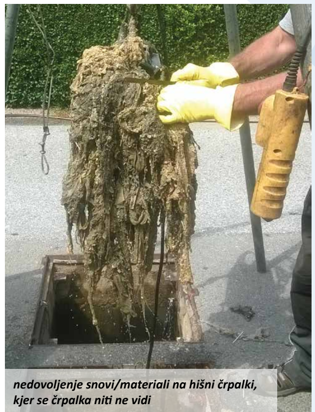
nedovoljene snovi/materiali v kanalizaciji
